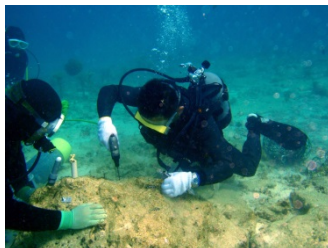
①岩盤に穴を開けます。
