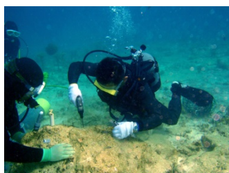
①岩盤に穴を開けます。
